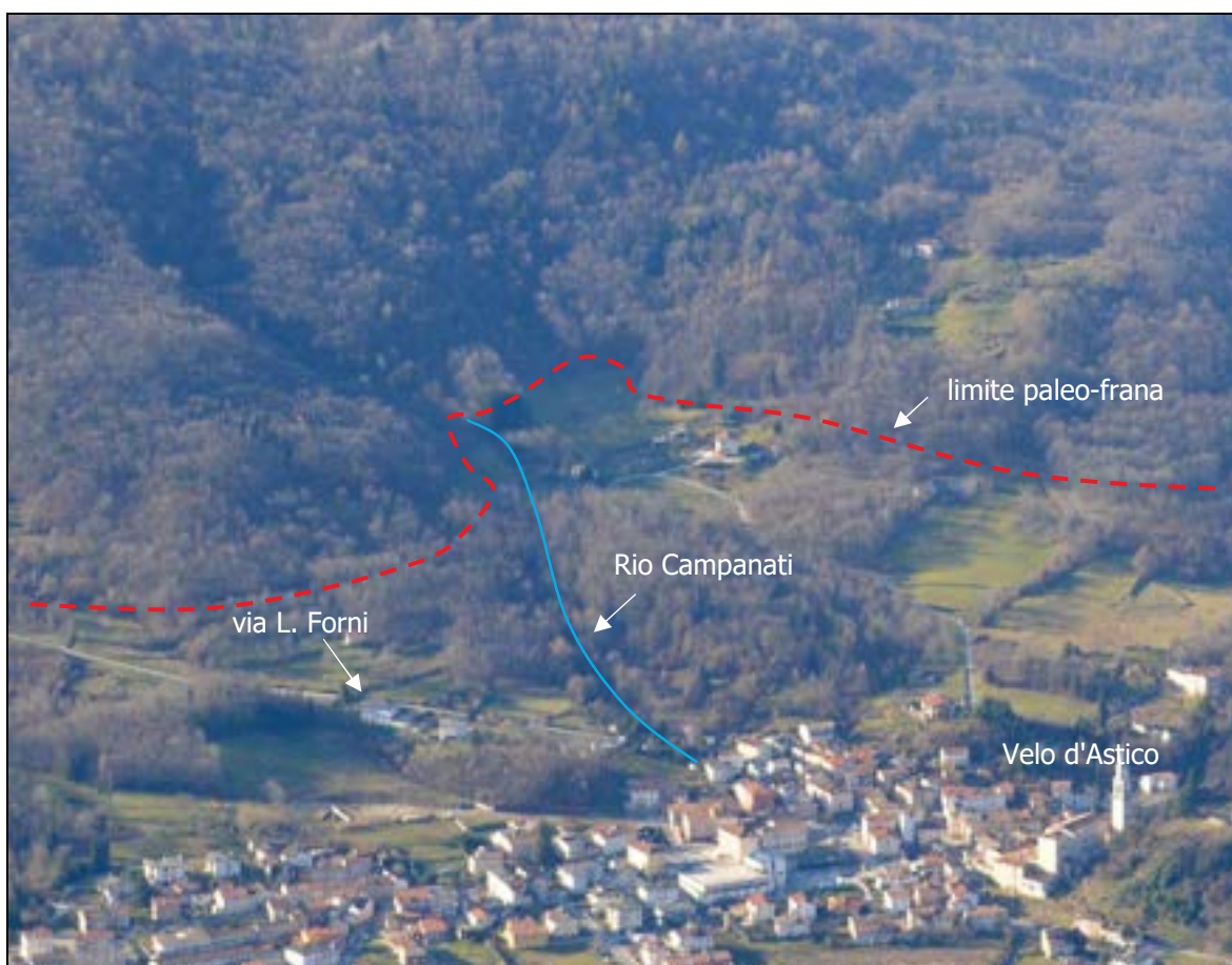
panoramica da nord dell'area oggetto di studio
