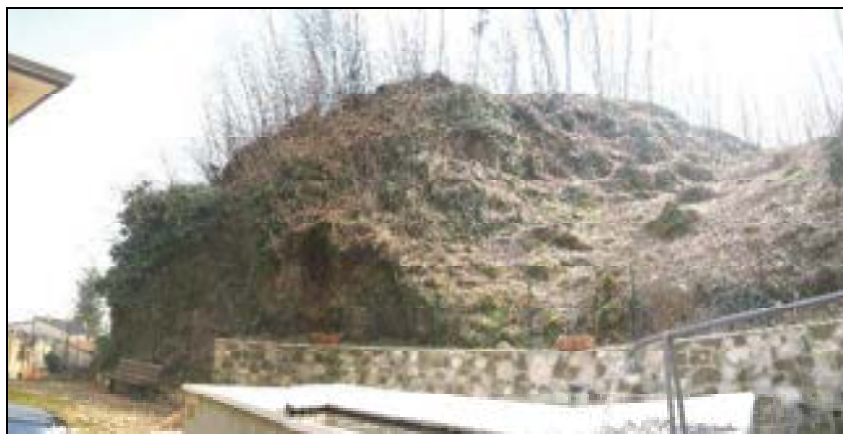
vista di parte della parete oggetto di studio
