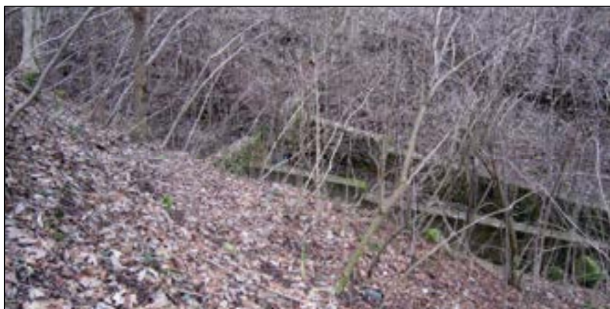
vista della briglia a valle della quale il corso d'acqua è regimato
