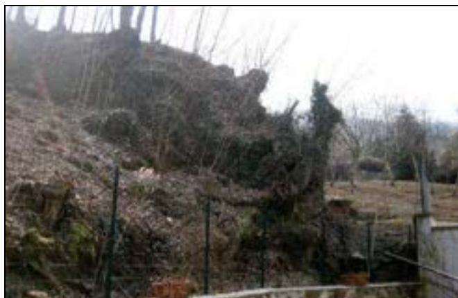
vista di parte della parete oggetto di studio
