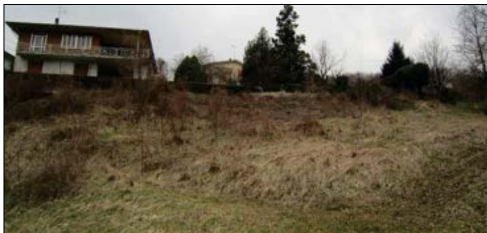
vista del dissesto n. 2
