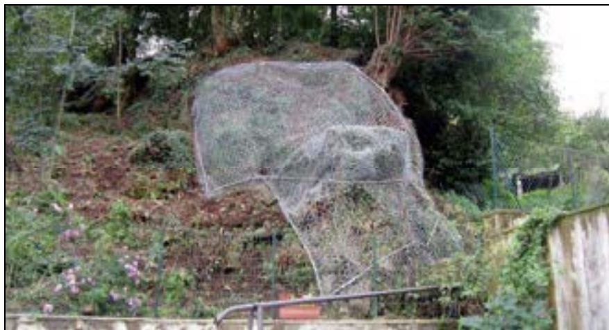
vista dell'area in dissesto sistemata con rete paramassi
