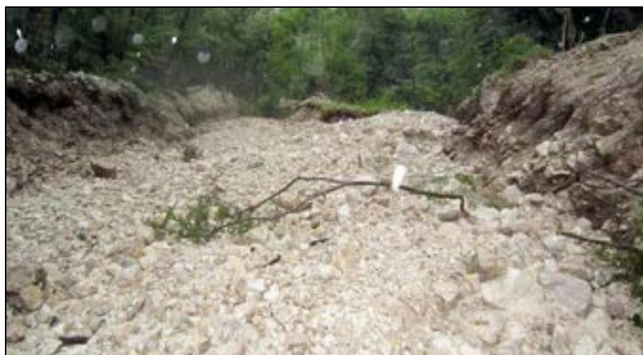
vista della parte intermedia del canale in erosione nella zona di trasporto
