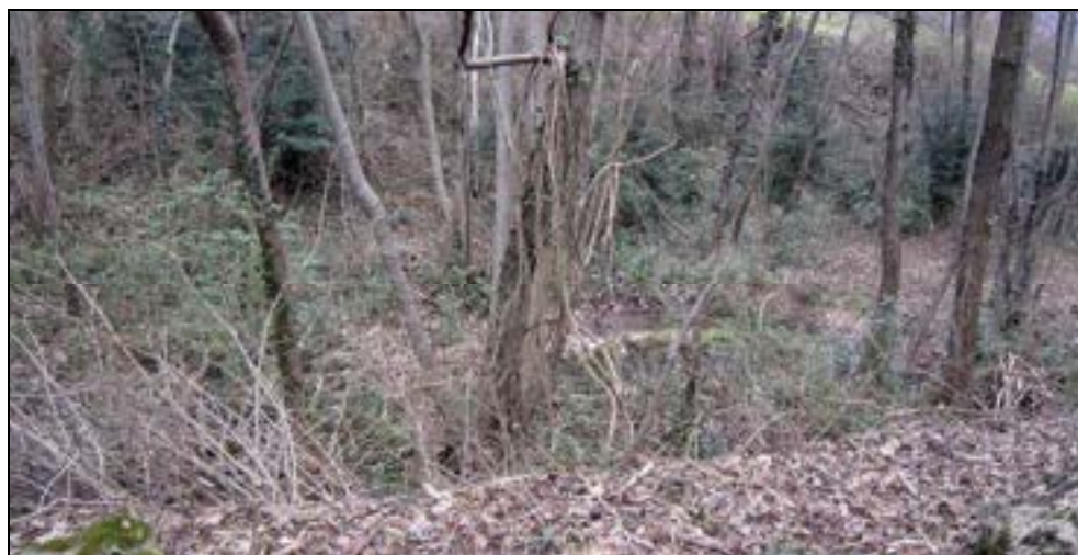
vista del dissesto n. 7
