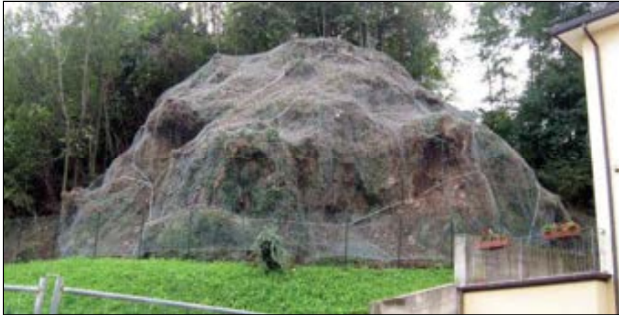
vista dell'area in dissesto sistemata con rete paramassi
