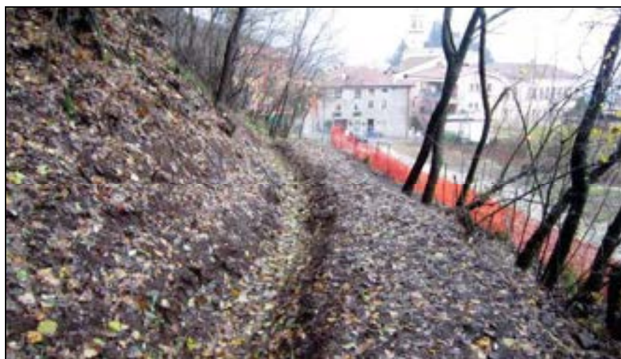
- vista del piccolo vallo realizzato in sostituzione della rete di protezione -
