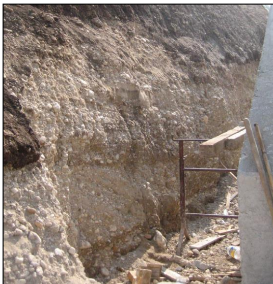
Depositi fluvioglaciali in un cantiere a valle dell'abitato di Velo in località La Fabbrica
